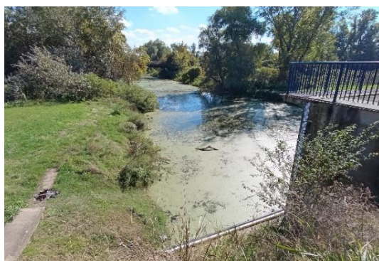
Слика 2.9 – Одводни канал црпне станице „Галовица“
